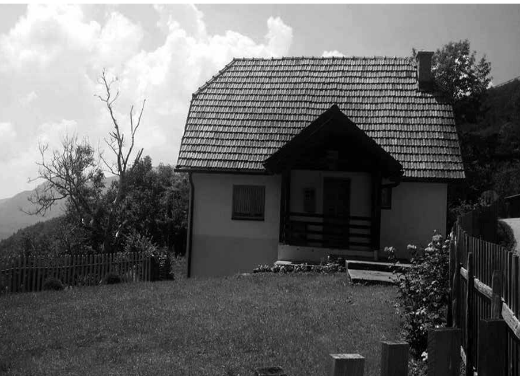
Porodična kuća Husein-ef. Đoze u selu Bare kod Goražda
